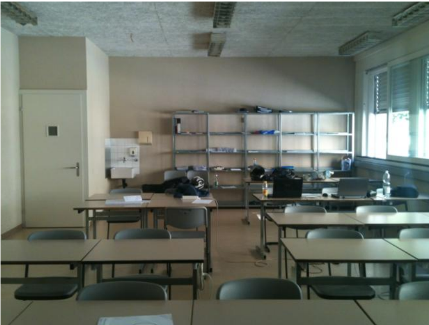
Zimmer O14, Boden: Linoleum, Mauerwerk, Decke: Platten, Fenster: Schiebetüren, Beleuchtung: Neonröhren
