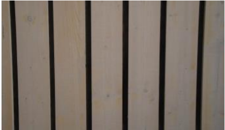
Decke, abgehangen mit Holzleisten
